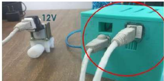
Fig. 10. Prueba de conectividad y alimentación con válvula solenoide de 12V.
